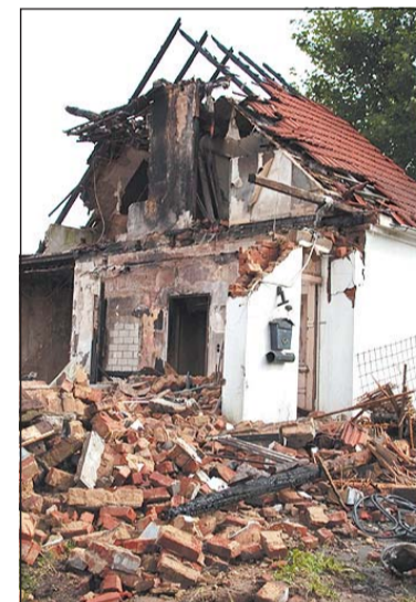
Der polnische Arbeiter ist unter Bauschutt begraben worden. Er erlitt schwere Verletzungen.
